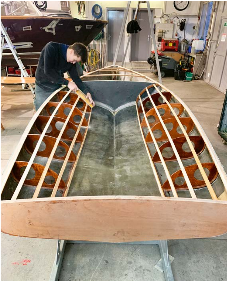
RÉCEMMENT SORTI DES PLACARDS DU CHANTIER, CE MOTH JAUGE 1945 EN COURS DE RESTAURATION, L'UN DES PREMIERS PROJETS D'AUGUSTIN LÉPINE DU TEMPS DE SON APPRENTISSAGE.
